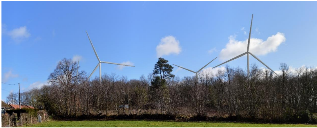
Vue sur le projet éolien depuis la limite est du Monteil
